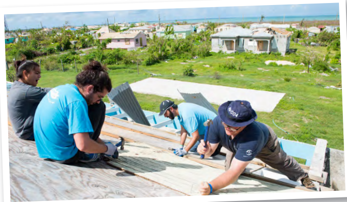
サマリタンズパースのボランティアと協力して建物の屋根を修理するスタッフ
