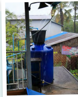
雨水と井戸水をためておく給水タンク
